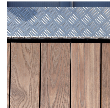
Mindestabstand zu anderen Bauteilen von 20 mm.
