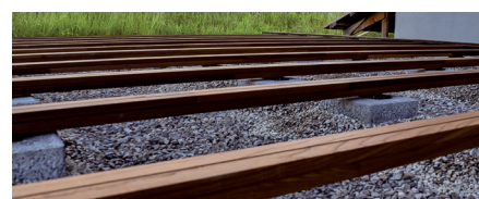
Unterkonstruktion nicht direkt auf den Untergrund setzen.
