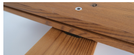
Holz- auf Holz-Verbindung meiden.
