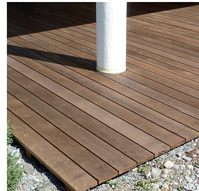
Frisch verlegte Terrasse
