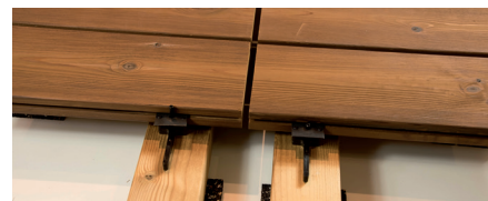
Die Längsstöße müssen auf zwei Unterkonstruktionshölzer liegen.
