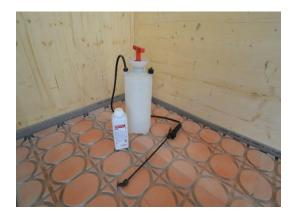
Die Grundierung dient als Haftbrücke zwischen Gips und Vergussmasse. Die Grundierung im Mischverhältnis 1 zu 4 mit Wasser verdünnen. Sie kann mit einem handelsüblichen Drucksprühgerät (Birchmeier) aufgetragen werden. Dabei ist zu beachten, dass sie gleichmässig auf dem gesamten Bereich aufgesprüht wird.
